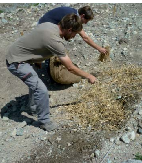
Inerbimento dimostrativo con idrosemina in Valgerola e, a destra, con fiorume in sito soggetto a spostamento terra in Val Pola.
