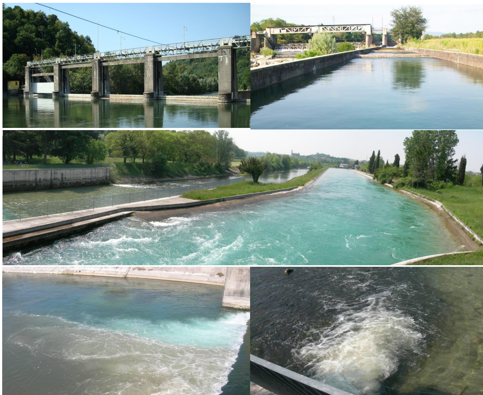
Figura 2 – le immagini si riferiscono ai fiume Oglio sublacuale (pannello in alto) e al Mincio (pannelli centrale e basso) e ne evidenziano la profonda manomissione sia per l’alterazione dei settori spondali e la costruzione di opere di presa (a scopi irrigui ed idroelettrici) che per l’immissione di acque reflue (evidente l’effetto di quelli veicolati al Mincio dal depuratore di Peschiera).
